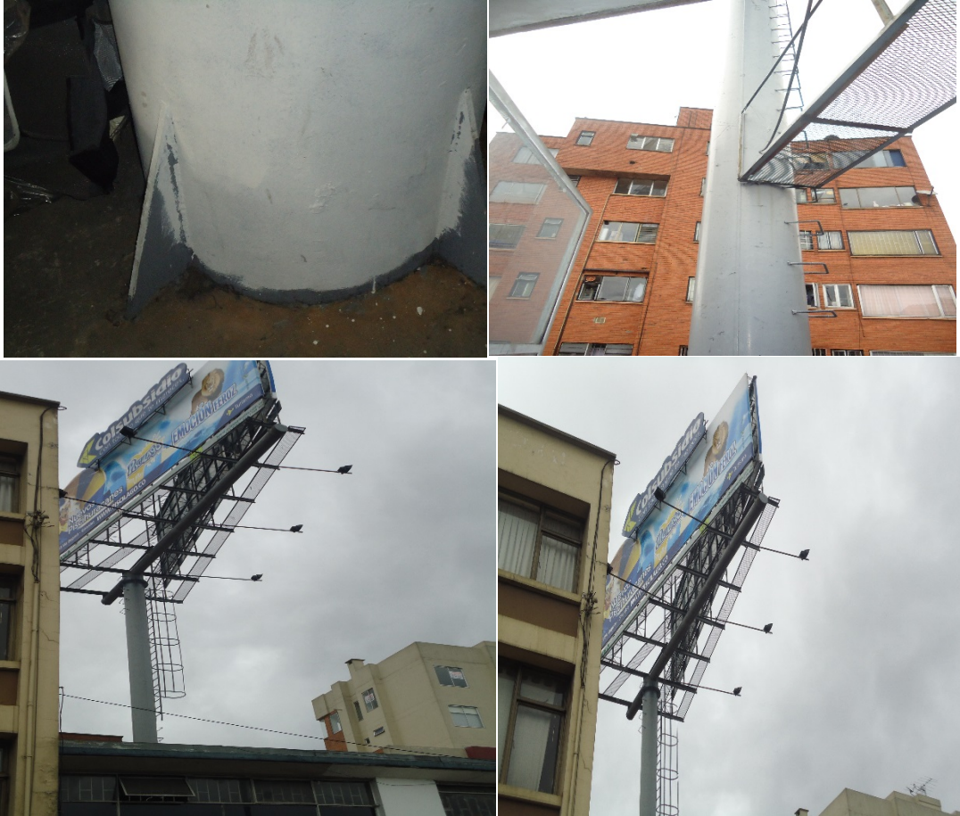
Vista Sentido Norte-Sur
